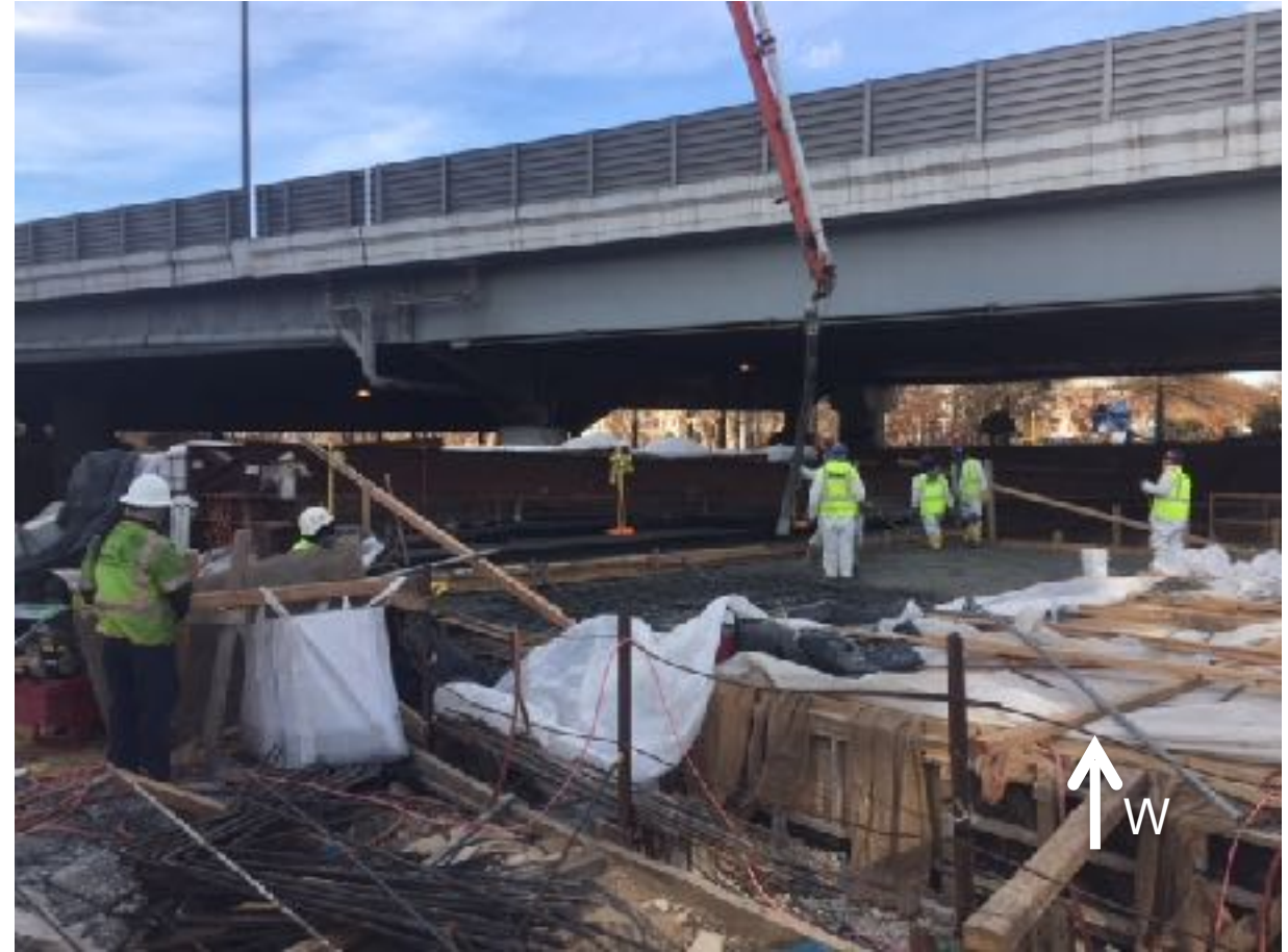
Tunnel Unit 1 Roof Pour
